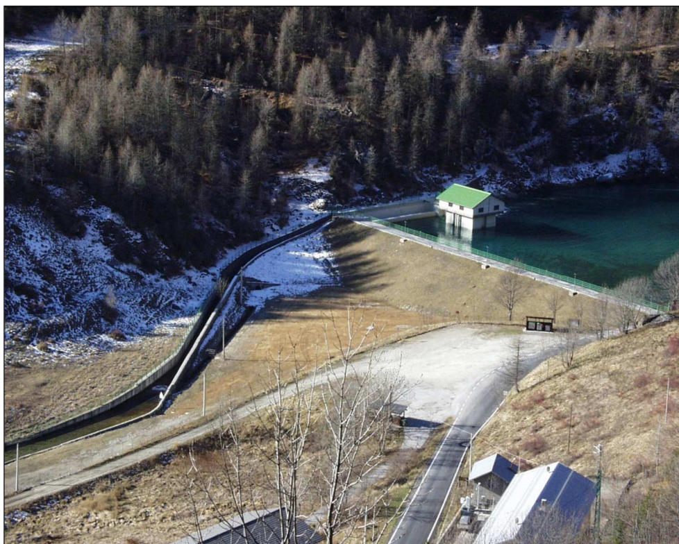
Figura 4.7.19 – Torre di presa e coronamento
