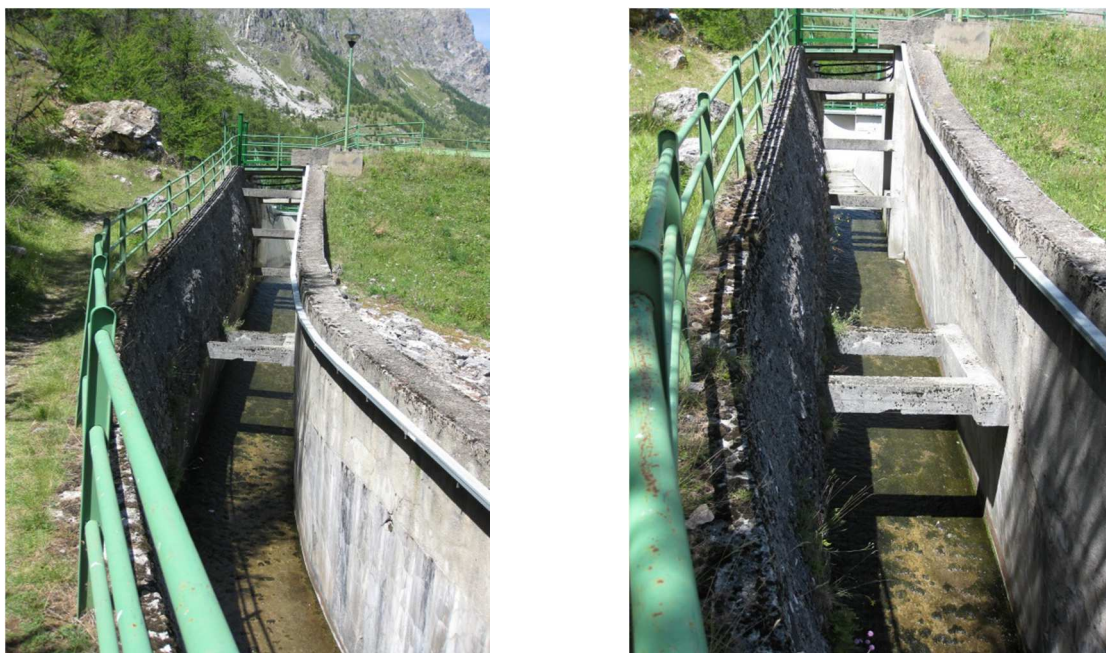
Figura 5.3.3 – Canale di scarico in destra orografica: si osservino le opere di contenimento realizzate per contrastare le spinte del versante
